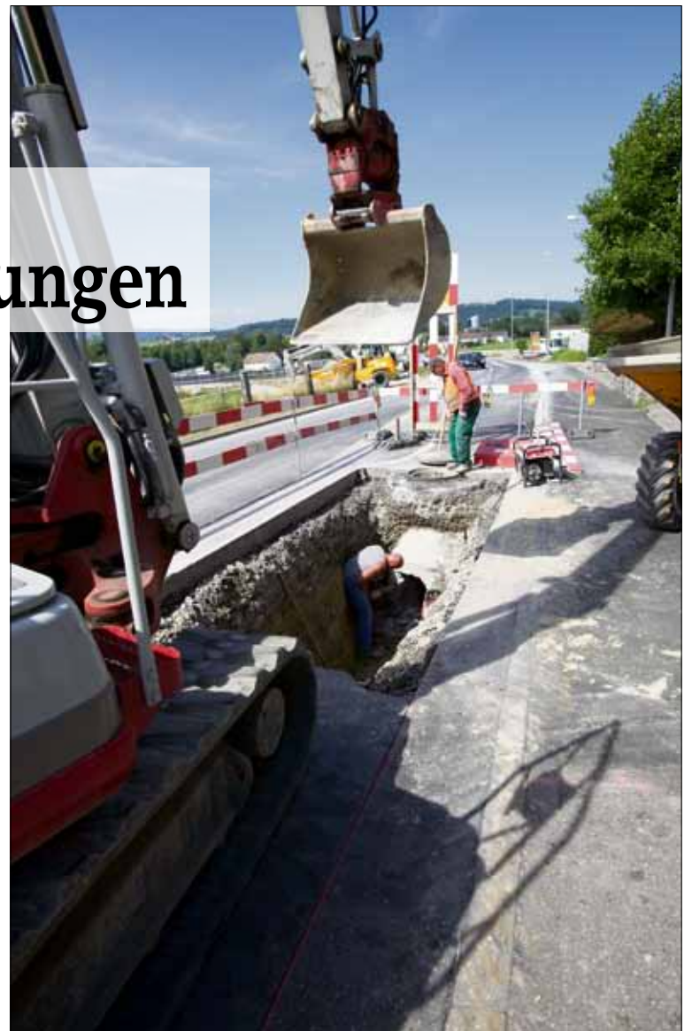
Arbeiten an der Kanalisation.
