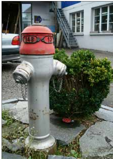
Die Hydranten werden revidiert.
